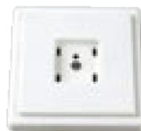
Nevyhovujúca telefónna zásuvka
